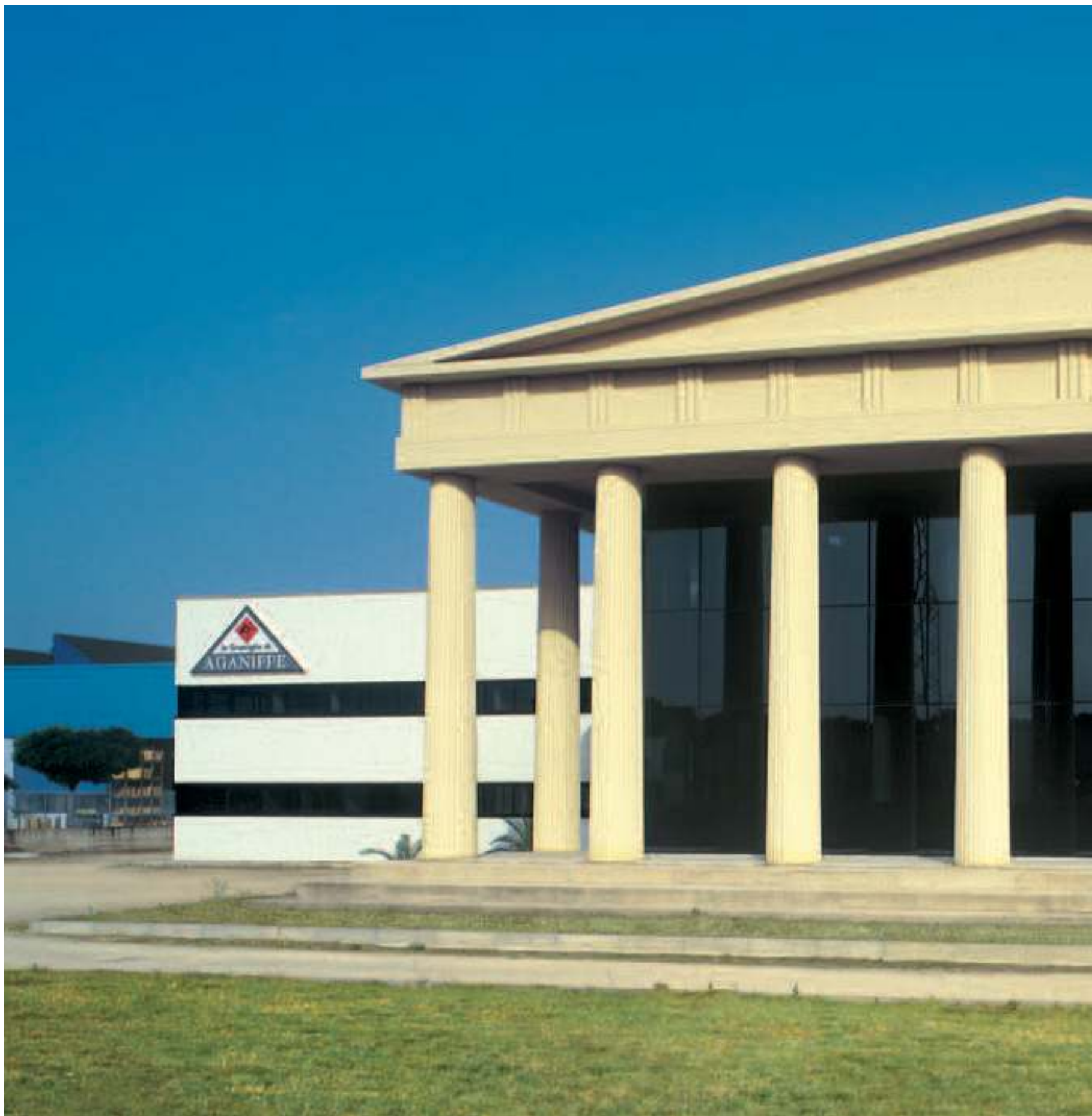
Lanciano (CH). Nuova sede della Ditta Aganippe Pavimenti/ Aganippe's new factory.
