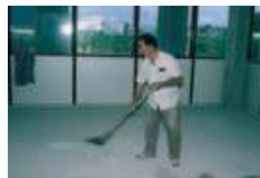
Pulizia del sottofondo.
