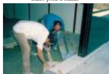
Posa a malta con spessori.
