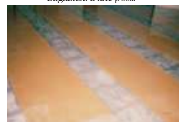
Stuccature delle fughe (1° colore)
