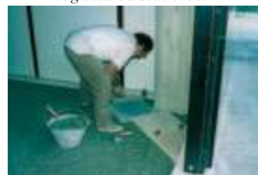
Inizio posa a malta.
