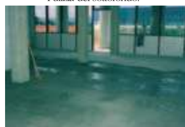
Bagnatura del sottofondo.
